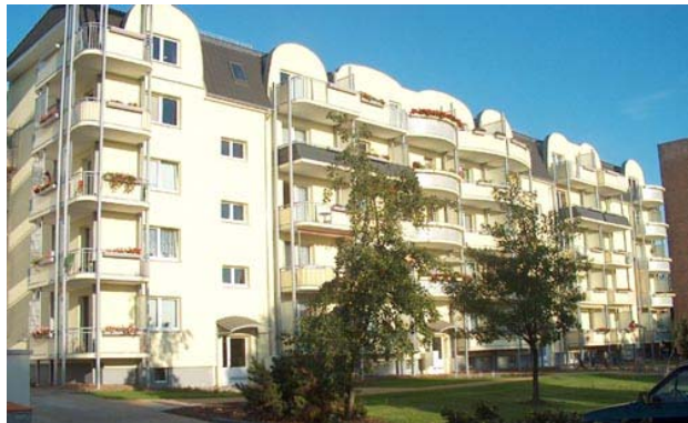
Abb. 1: Zustand nach Teilrückbau und Modernisierung, Templin Lychener Str. 44-47 (Mai 2004)
