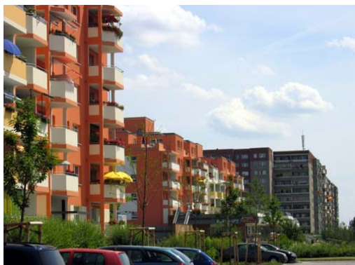
Abb. 6: Rückgebaute, modernisierte Plattenbauten in Berlin-Marzahn, Ahrensfelder Terrassen, Planung: Bauplanungs- und Ingenieurgesellschaften Schüttauf & Persike mbH, Berlin
