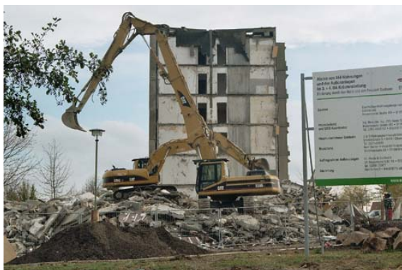
Abb. 5: Abbruch der Plattenbauten im 3. und 4. Bauabschnitt in der Kräutersiedlung
