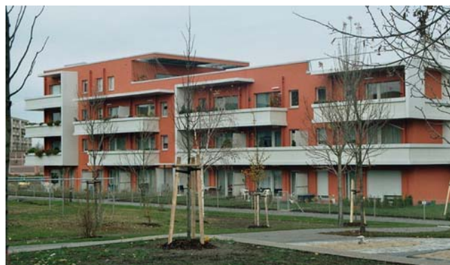
Abb. 3: Dresden, Kräutersiedlung 2. Bauabschnitt – Zustand nach Teilrückbau und Modernisierung, Planung: Architekturbüro Rolf Zimmermann, Dresden
