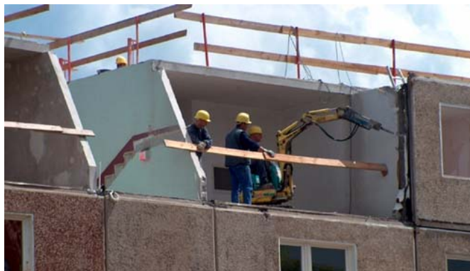
Abb. 2: Rückbauzwischenzustand: Dachgeschoss nach Außenwanddemontage und Schneidarbeiten
