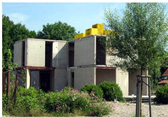
Abb. 8: Rohbau Einfamilienhaus in Mehrow, Planung: Architekturbüro CONCLUS, Berlin, Architekt: Herve Biele
