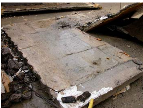
gereinigte Betonfläche optisch kein Kamilit mehr sichtbar
