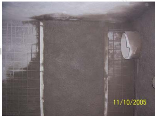
Reprofilierung der Wandflächen mit Spritzbeton im Trockenspritzverfahren (Spritzstärke bis 120mm)
