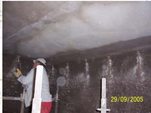
Erneuerung der Bewehrung/Zusatzbewehrung (HILTI, DIBT-Zulassung Z-21.8.1648)
