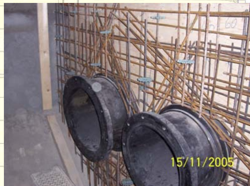
Stahlbetontrennwand mit Doppelflanschen und Dammbalkenverschlüssen
