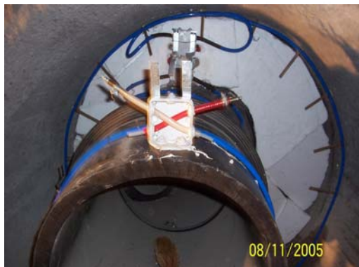
Eindichten von Rohrdurchgängen (Epoxidharz-Verpressschläuche)
