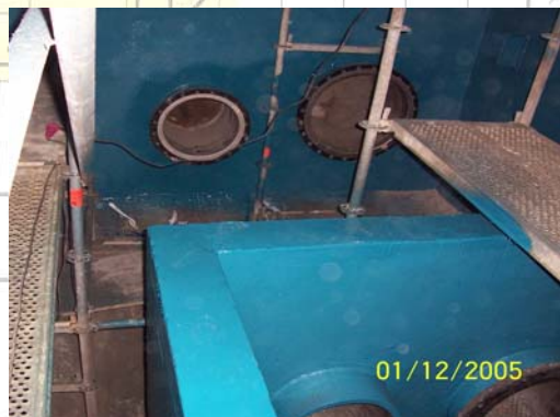
Nahtlose Beschichtung incl. aller Ein- und Anbauteile (chemisch hoch belastbar)
