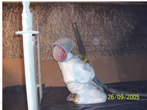
Auftrag von Spritzbeton in schwierigen Bereichen (Deckenuntersichten, Spritzstärke bis 90 mm)
