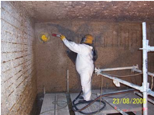
Entfernen des schadhaften Betons (Höchst-/Hochdruckwasserstrahlen-, Sandstrahlen)
