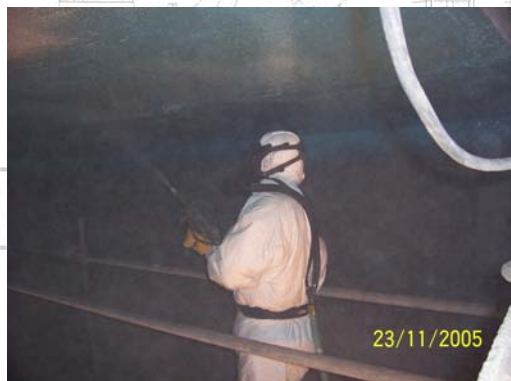
2-K-Spritzverfahren mit Polyurethan OLDODUR WS 56 (beständig gegen biogene Schwefelsäure)
