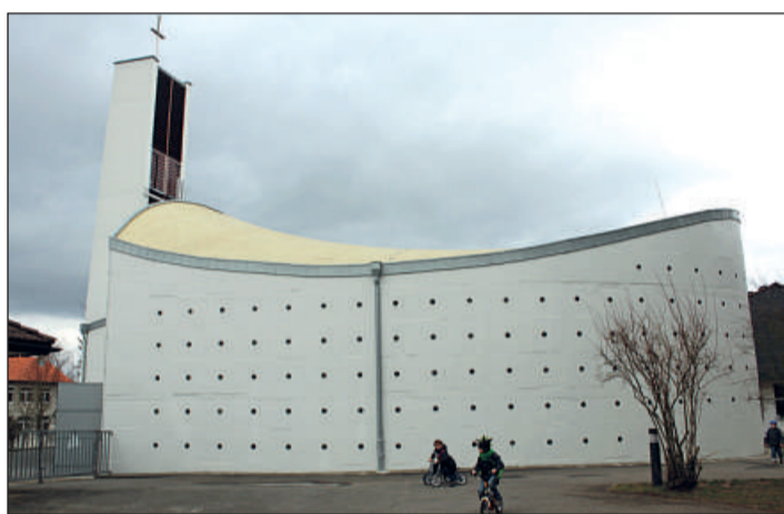
Das Dach von St. Bonifatius ist das Hauptkennzeichen und einzigartig in der Kirchenarchitektur. Es wurde umfassend saniert.
