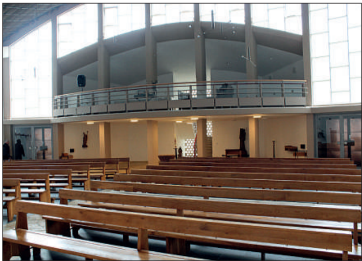
Die große Fensterfront über der Empore erhielt eine Isolierverglasung und wärmedämmende Profile.
