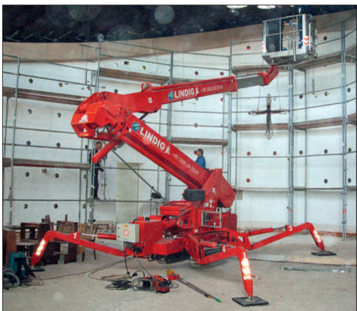
Futuristisch mutete der Hubsteiger im Kircheninnenraum an, der für die Sanierungsarbeiten nötig war. Foto: Kling
