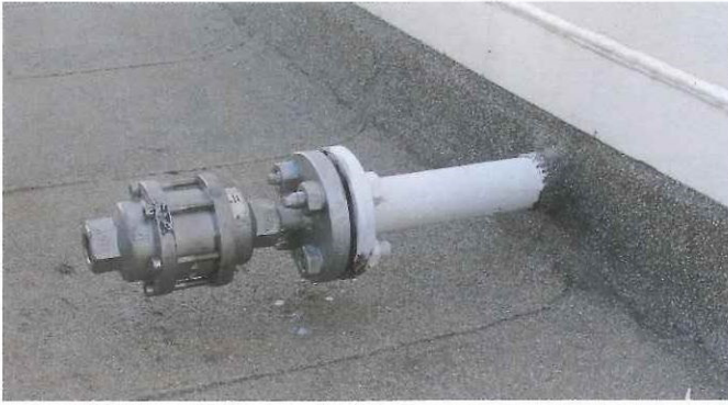
Bild 3 Auskleidung von Tank-Auffangräumen mit brandhemmender elastischer Zusatzbeschichtung.
