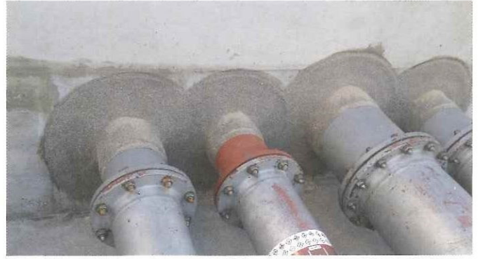
Bild 4 Elastische Rohrmanschetten mit brandhemmenden Zusatzbeschichtungen.
