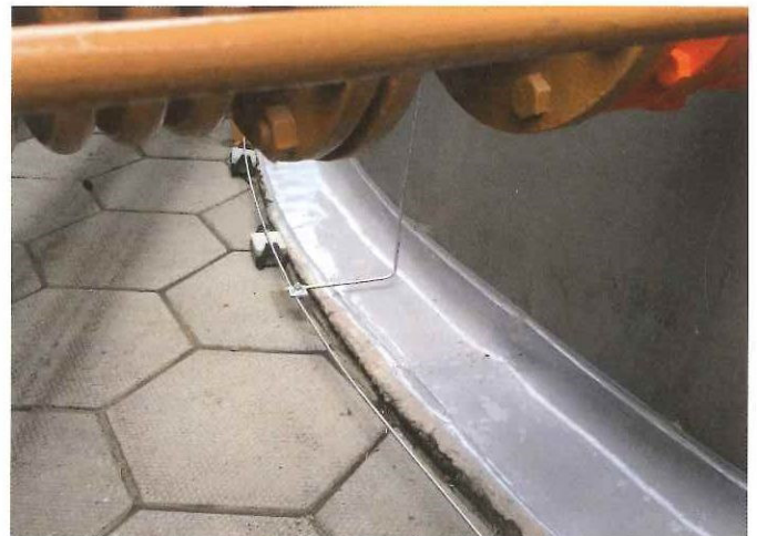
Bild 2 Hochelastische Tankfußschürze am Mantel und am Fundament verklebt.
