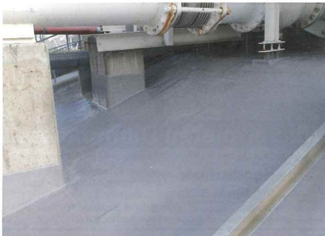
Bild 1 Hochelastische Flächenauskleidung an einer Tankwarft.
