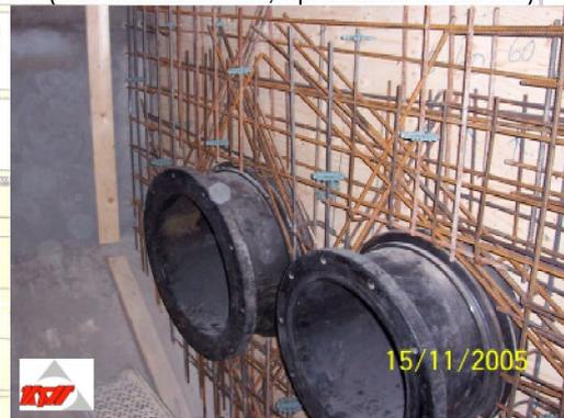
Stahlbetontrennwand mit Doppelflanschen
