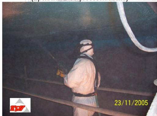
2-K-Spritzverfahren mit Polyurethan OLDODUR WS 56
