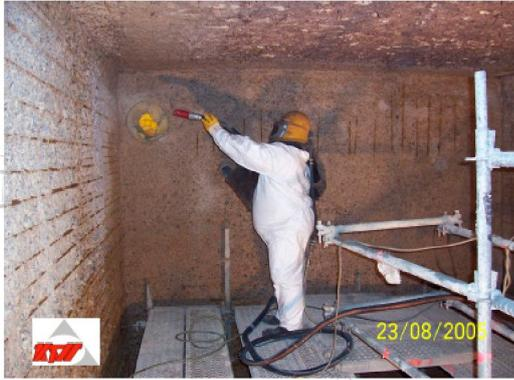
Entfernen des schadhaften Betons
