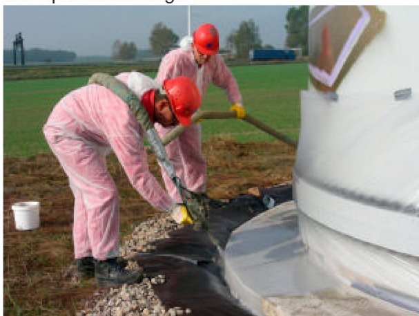
Hochelastische Spritzabdichtungen mit 500% Dehnung, nach 15 Minuten begehbar
