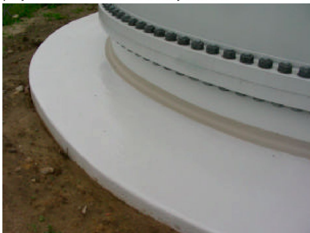
Kombination von Fugenbändern (Bewegung im Zentimeterbereich möglich) und Spritzabdichtungen
