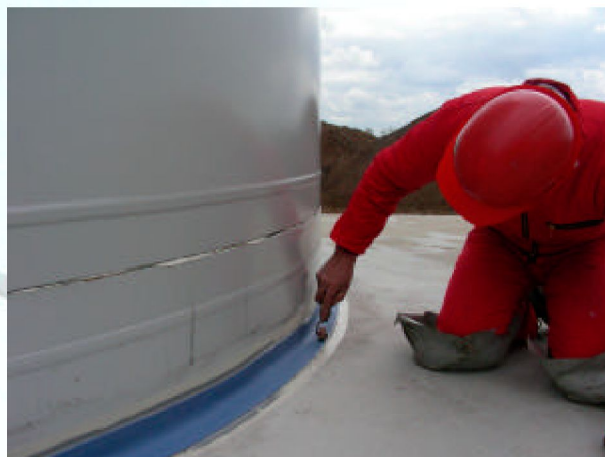
Dauerhafte Abdichtung zwischen Turm (FET) und Betonfundament
