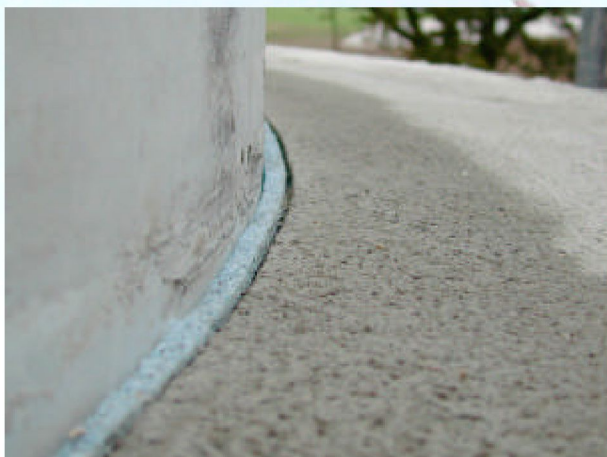
Bewegungsentkoppelte Betoninstandsetzung mit polymermodifizierten Mörtelsystemen
