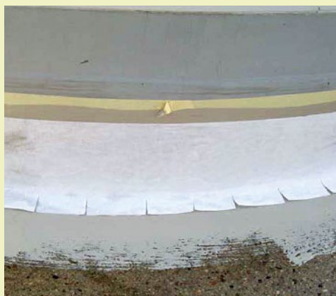
Vliesarmierte Abdichtung des Turmanschlusses und der Betonfläche als rissüberbrückende Komponente
