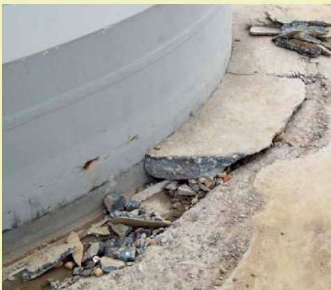
Schaden: Betonabplatzung
