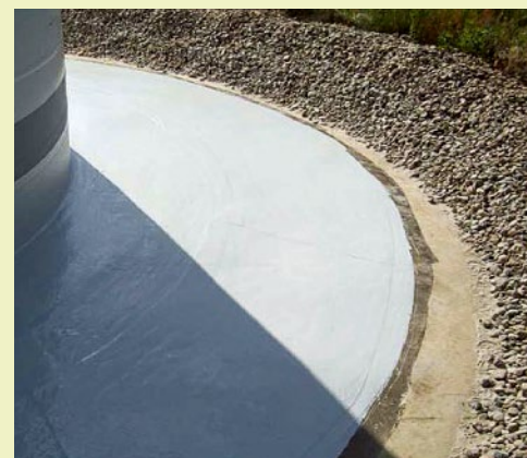
Versiegelung des Abdichtungsmaterials
