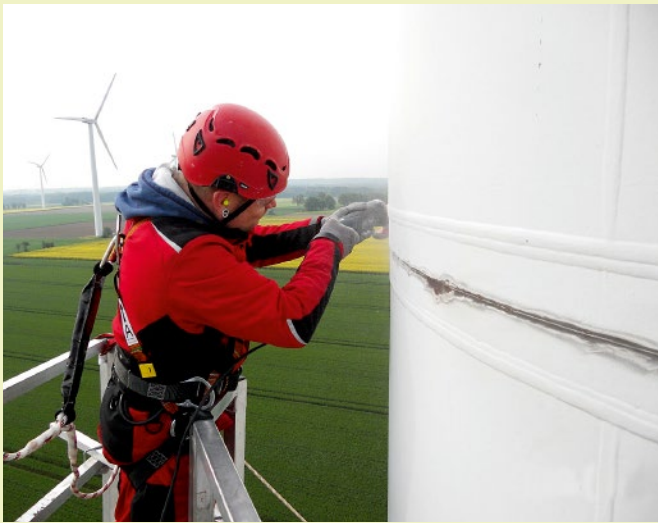
Beseitigung eines Korrosionsschadens am Stoß der Turmsegmente
