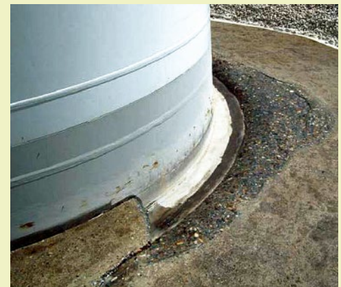
Grundierung als Haftgrund für die später aufzubringende Abdichtung
