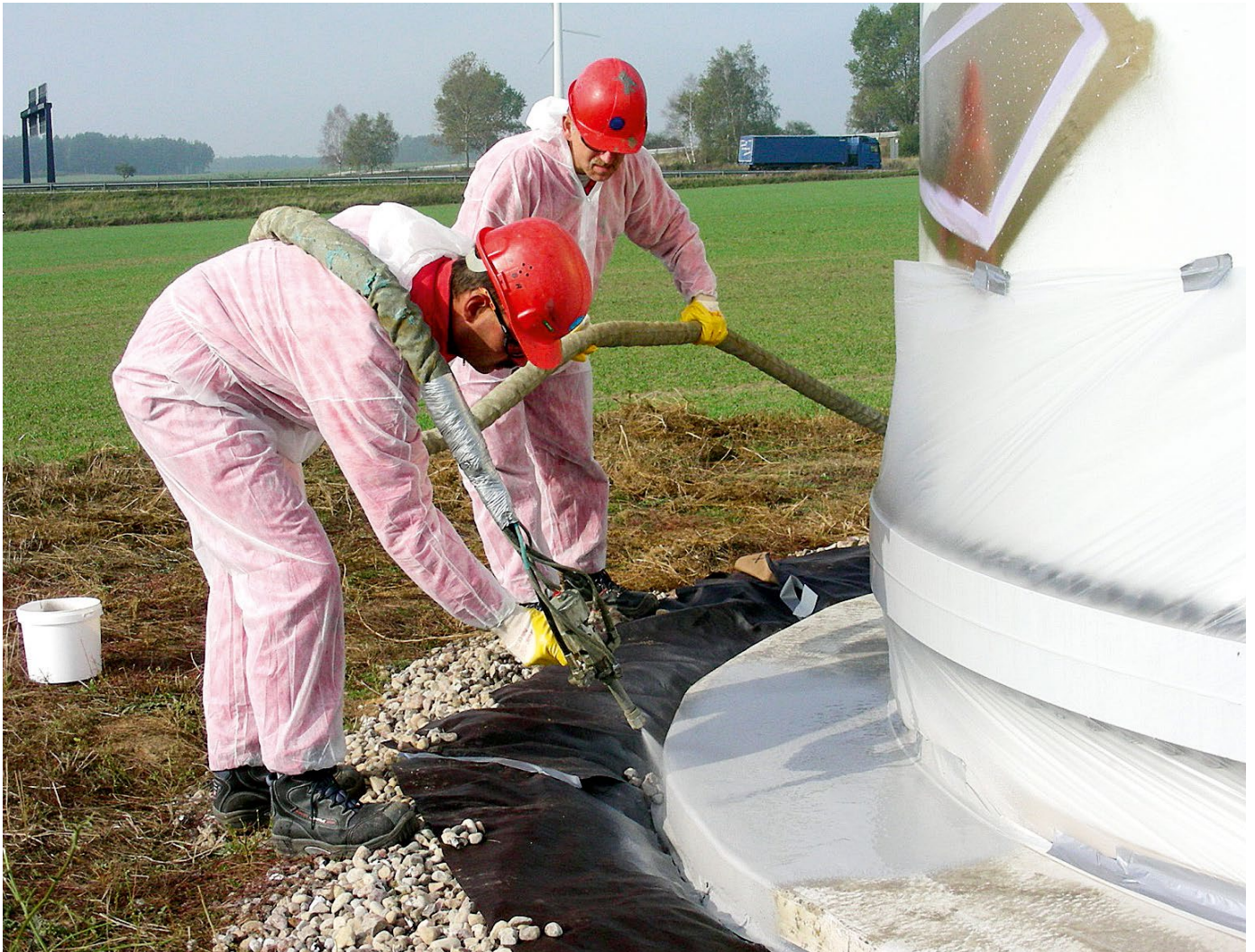
Sanierung eines Sockelfundaments mit hochelastischer Polyurethan-Abdichtung
