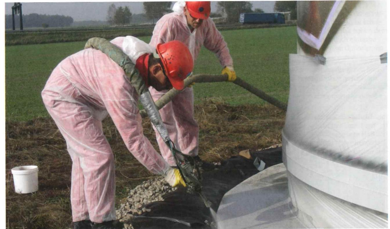
Bild: Sanierung eines Sockelfundaments mit hochelastischer Polyurethan-Abdichtung (KTW Umweltschutztechnik GmbH)
