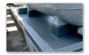
Auskleidung von Leckageauffangräumen Lining of leak-catchment areas
