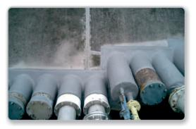
Elastische Einbindung von Rohrtrassen in WHG-Flächen Elastic integration of pipeways in areas subject
