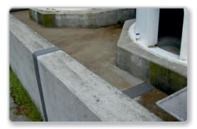
Fugenabdichtung mit vorkonfektionierten Polysulfid-Fugenbändern Joint sealing using prefabricated polysulphide joint-sealing strips
