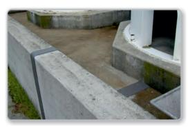
Fugenabdichtung mit vorkonfektionierten Polysulfid-Fugenbändern Joint sealing using prefabricated polysulphide joint-sealing strips
