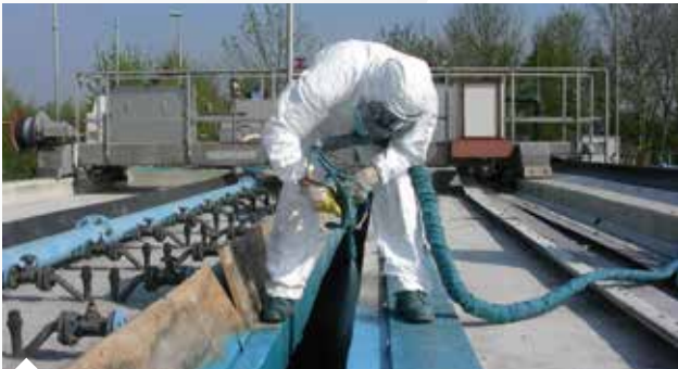
Spritzauftrag einer PU-Heißspritzbeschichtung
