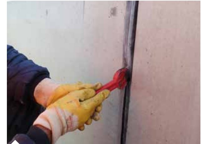
Einbringen von Einschlagprofilen in Bauteil-Fugen
