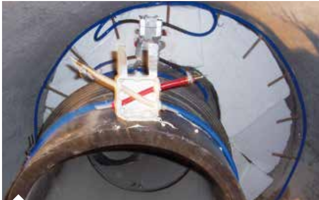
Eindichten von Rohrdurchgängen mit Verpressschläuchen
