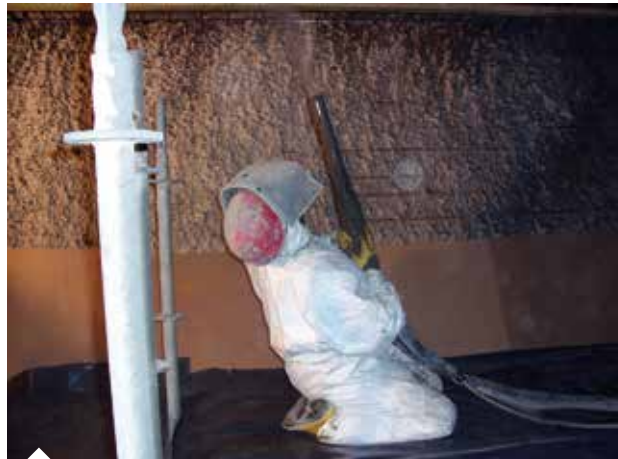
Aufbringen von Spritzbeton in schwierigen Bereichen, wie z.B. Deckenuntersichten
