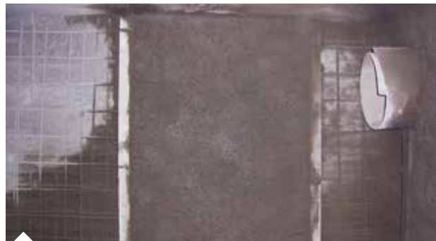
Reprofilierung der Wandflächen mit Spritzbeton und Ergänzung von Bewehrung
