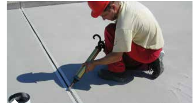
Fugenabdichtung mit elastischen und beständigen Dichtstoffen
