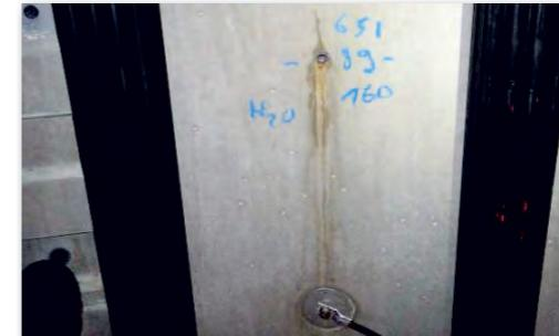
Wasserführende durchgehende Risse an Innenseiten der Adapterelemente
