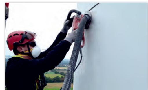
Untergrundvorbereitung durch Anschleifen der Betonoberfläche
