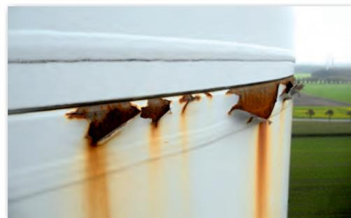
Korroderte Stoßfugen, gegebenenfalls auch mit Flanschklaffung
