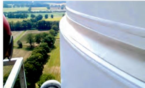
Elastische Polysulfid-Fugenbänder im Übergang zwischen Adapterelement und erstem Stahlurmsegment
