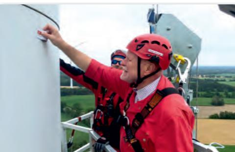
Handnahe Prüfung am Übergang zum ersten Stahlurm
