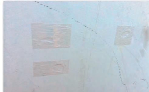
Partieller Korrosionsschutz in Turmfarbe
