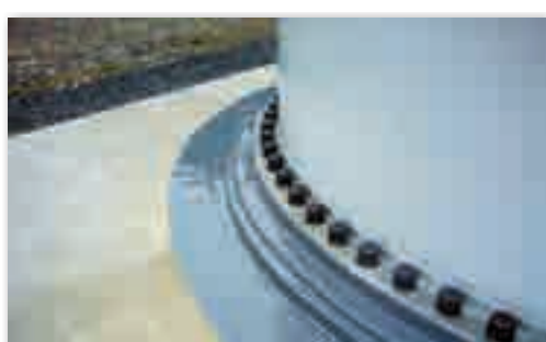
Elastische Abdichtung auf feuchten Untergründen (bis 20% Restfeuchte) Elastic sealing on moist substrate (till 20% restmoist)
