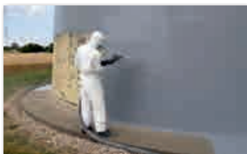
Hochelastische Flächenabdichtung mit 500% Dehnung (im 2-K-Heißspritzverfahren, nach 15 Minuten begehbar) Highly elastic sealing membrane with 500% extension (2-k-spraying process, accessible after 15 minutes)
