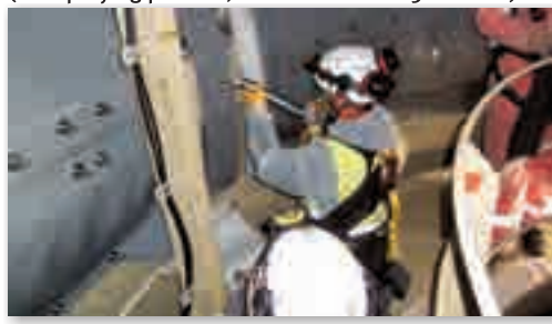
Spezialabdichtungen von Flanschverbind- ungen an Offshore-Windenergieanlagen Special sealing of flange connections at offshore-wind turbines
