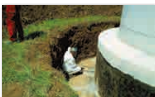
Fundamentverpressung ohne Beschädigung der Bewehrung Foundation grouting without damage to reinforcement
