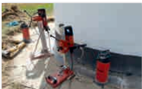
Kleinstbohrungen zum Fundamentein- bauteil bis 2 Meter Tiefe Small drilling to the foundation segment until 2 meters depth
