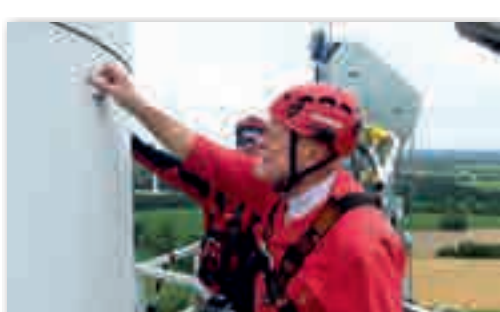
Handnahe Prüfung am Übergang zum ersten Stahlturm Ready-to-hand testing at the transition to the first steel tower
