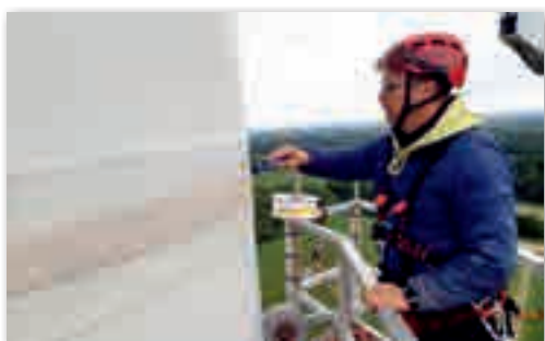
Langlebige, hoch uv-beständige Fugen- bänder UV-resistant, long lasting joint tapes
