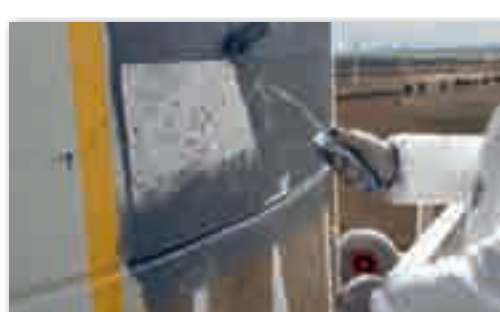
Einbetten der Glasfaser-Armierung in die hochelastische Abdichtung Embed of the glass-fibre reinforcement into the highly elastic sealing
