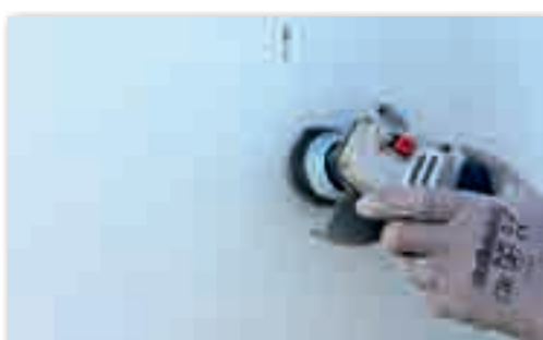
Ausschleifen von Roststellen Grinding of corroded spots
