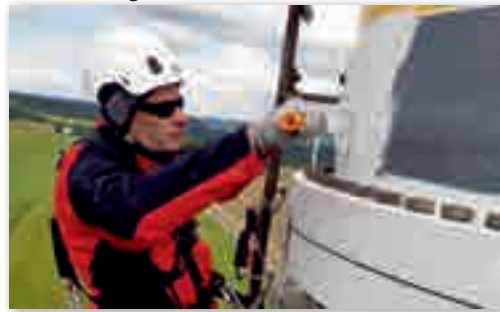
Einbau der hoch uv-beständigen, elastischen Deckbeschichtung Installation of the highly UV resistant elastic deck coating
